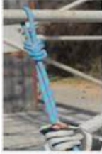
Doğru bağlantı yöntemleri ile kurulmuş ankrajlar
