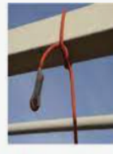
Hatalı Kurulmuş Ankrajlar
